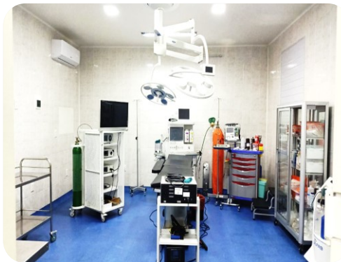
Remodelación de Quirófano – Esterilización
